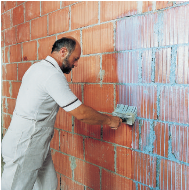
PCI Gisogrund verbetert de hechting van gipspleister op metselwerk.
